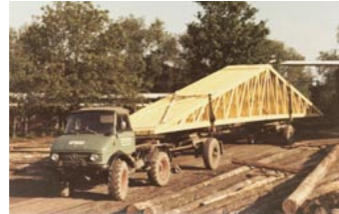
Transport einer Holzbinder-Konstruktion.
