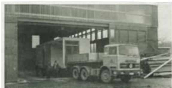
Als vierjährige Bauzeit mit Otto Baukmeier jun. am Ende steht, ist die Baustelle nach Abschluss der Bauarbeiten schon schon im Sommer 1983 im hochmodernen Produktionsbetrieb. Der Fertighaus wird nach den Vorstellungen der Firmenkunde vom Keller bis zum Dach für etwa 100 000 Mark auf dem Markt kommen.
