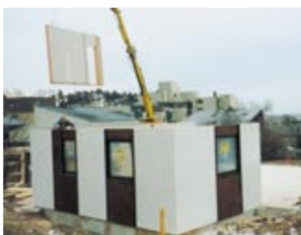
Aufbau eines Fertighauses 1985.
